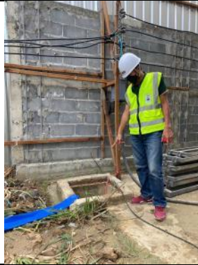
รูปที่ ๗7.38 เจ้าหน้าที่ความปลอดภัยดูแลตรวจสอบปริมาณตะกอนดินที่สะสมอยู่ในบ่อดักตะกอนดิน และชุดลอกตะกอน (ช่วงก่อสร้าง)
